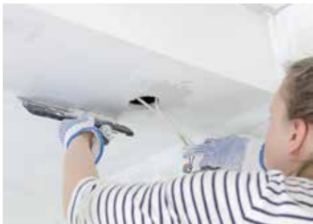
Abb. 9: Bekleidung von Stahlträgern, einlagig
